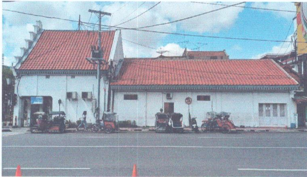
Foto 8. Bangunan Eks-Salon en Coiffeur tahun 2024 tampak samping (sisi utara)
