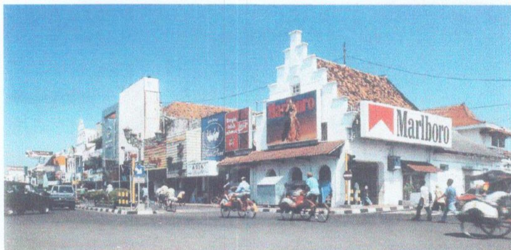
Foto 4. Bangunan Eks-Salon en Coiffeur di Jalan Malioboro tahun 1998 (Sumber Foto: T. Aartsen, dalam Djokja en Solo: Beeld van de Vorstensteden, 1998: 131)
