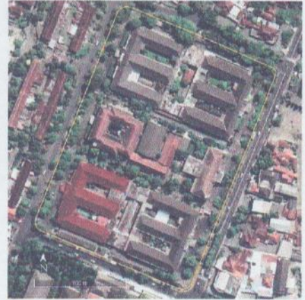
Gedung Tjahjono Adi dalam Kompleks Pantja Dharma
