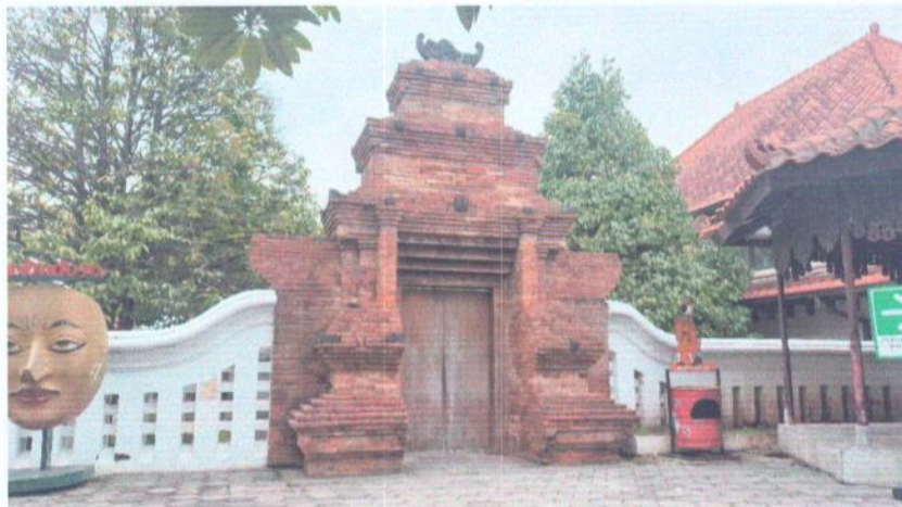
Foto 13. Akses penghubung antara halaman Gedung Karsten dengan halaman Pendapa Kesenian (Pendapa Ageng) Sumber Foto: Dinas Kebudayaan DIY, 2024
