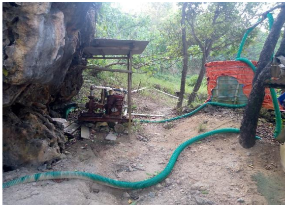
Saluran Irigasi dan Kolam Penampungan
