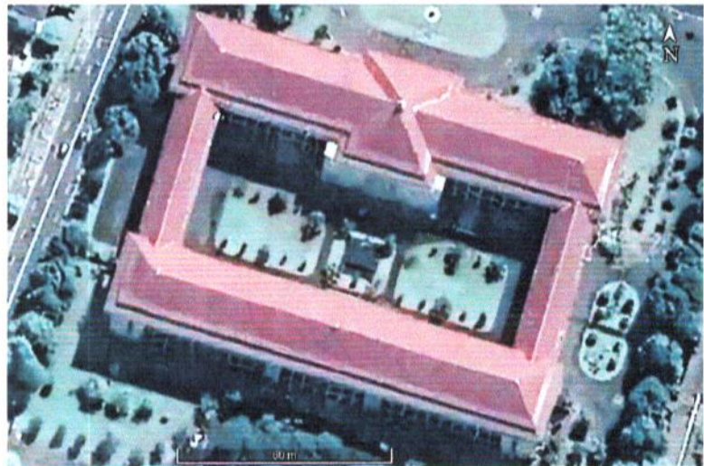
Empat unit bangunan Gedung Pusat UGM Sumber: Citra Satelit Google Earth, 4/2018
