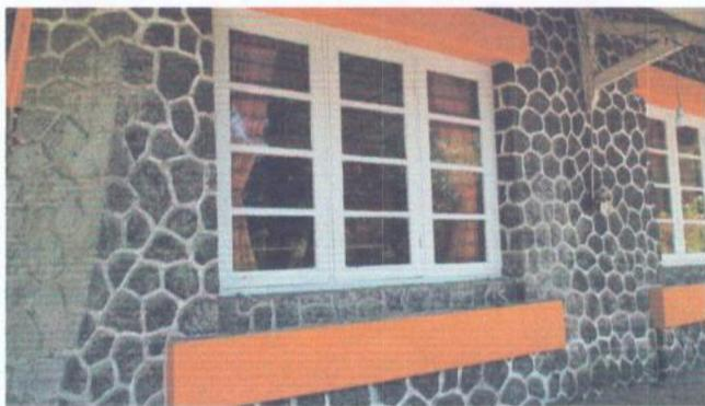
Gambar 6. Komponen *subsille/sill drip molding* pada ambang bawah setiap jendela
