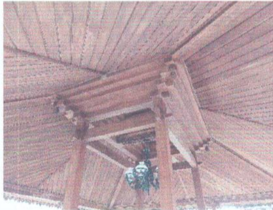
Konstruksi Tumpangsari pada Pendapa
