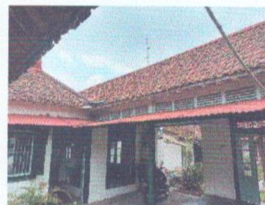
Bagian atap bangunan samping sisi timur pendapa yang menjadi satu dengan gandok kiwa
