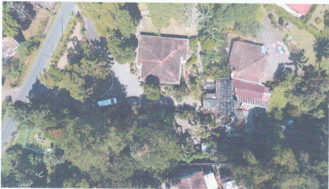
Gambar 16. Foto udara Bangunan Wisma Merapi Indah I Sumber: Dinas Kebudayaan DIY, 2024
