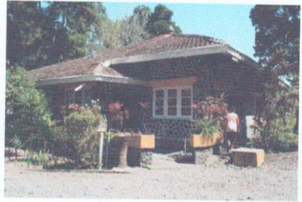
Gambar 14. Bangunan Wisma Merapi I Sumber: Dinas Kebudayaan DIY, 2024
